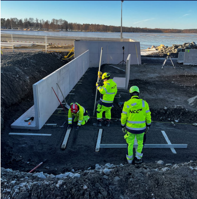
Noden montage av L-stöd för kommande trallyta.
