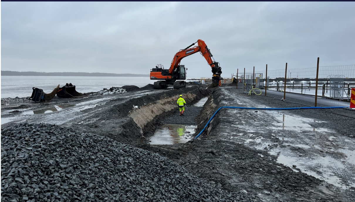
Pumpstationen är monterad i piren, just nu ansluts tryckledningar
