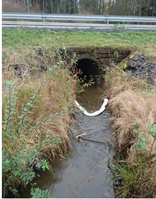
Figur 9. Trumman under Wennerbergsvägen. Terrasserna längs diket nedströms trumman översvämmas troligen vid högflöden.
