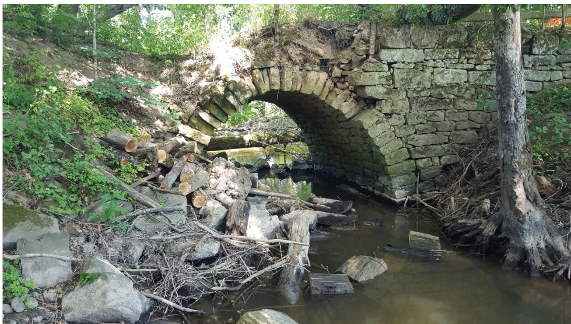
Figur 32. Öredalsån, objekt C. Stenvälsbro med anslutande vägbank som är upptagen i fornlämningsregistret. 18 juli 2017.
