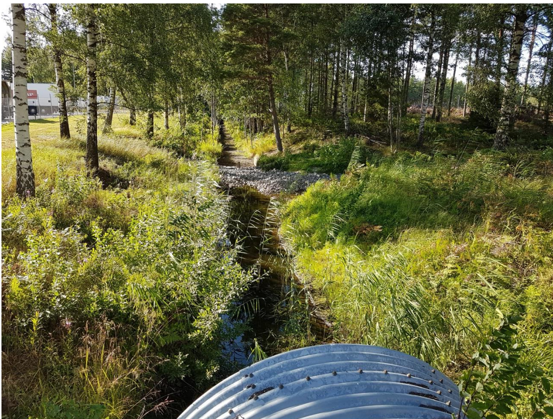
Figur 10. Brantabäcken, objekt B, vid Änghagens verksamhetsområde, nedströms väg 44 och strax uppströms dämning för vattenavledning till sidofåra mot nordost. 18 juli 2017.
