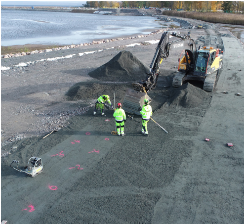
Justering av grusbädd för betongmur
